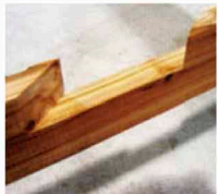
■間柱の筋交い欠き加工
