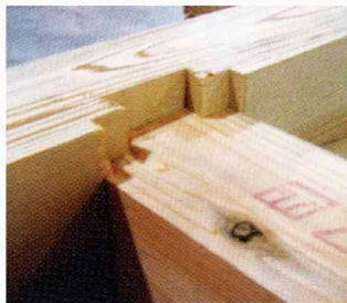
■段差加工 加工仕口の段差加工（アリ、カマ、茶臼、他）
