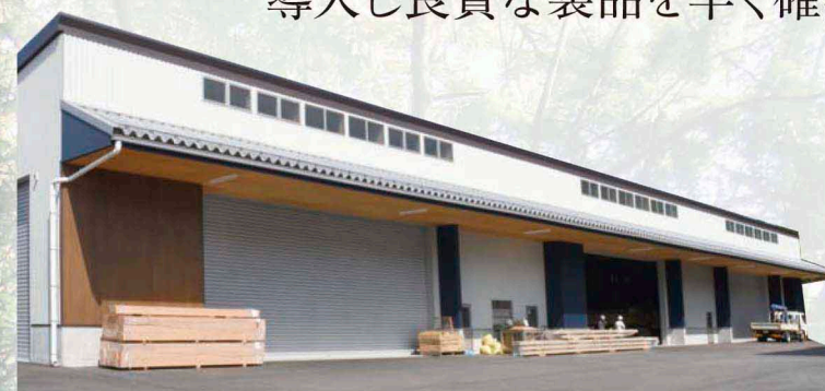
第三工場 大断面・CLT加工棟
